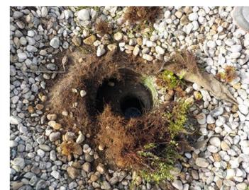
Apparition de mousse et de végétaux non désirés dans les organes d'écoulement (naissance). Risque que la toiture se mette en pression et que cela provoque des infiltrations.
