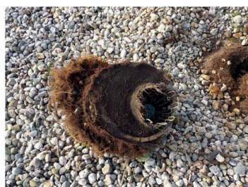
Apparition de mousse et de végétaux non désirés en toiture. Risque de perforation de la membrane d'étanchéité.
