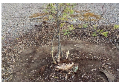
Apparition de mousse et de végétaux non désirés en toiture. Risque de perforation de la membrane d'étanchéité.
