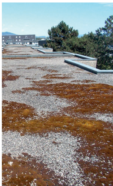
Apparition de mousse et de végétaux non désirés en toiture. Risque de perforation de la membrane d'étanchéité.
