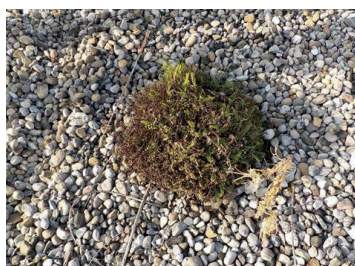
Apparition de mousse et de végétaux non désirés en toiture. Risque de perforation de la membrane d'étanchéité.
