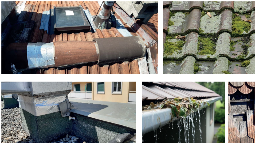
Contrôle de ferblanterie, des raccords d'étanchéité, de l'état des tuiles et de la sous-couverture.
